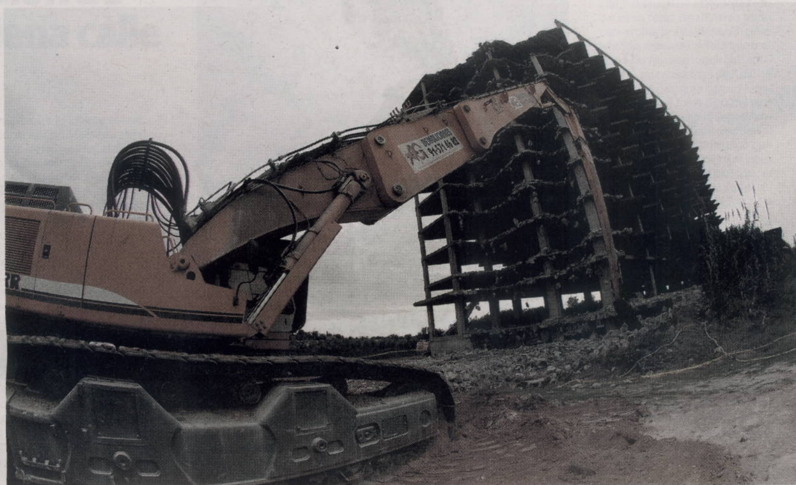
La empresa contratada por el Marbella Golf Country Club trabaja en el derribo de la estructura de once plantas desde hace unos días. :: J-L
